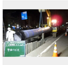
(写真:長崎市内で行われている配水管の敷設工事(2022年、長崎市上下水道局提供))
