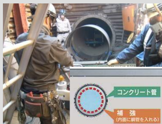
管路の耐震補強
